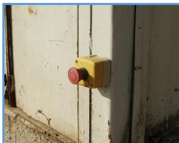
*Dispositif d'arrêt d'urgence mis en place sur une installation sur le site de Matignicourt-Goncourt (51), exploitée par la société SCE – Établissement Morgagni*
